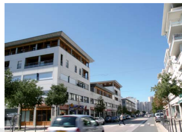
La ZAC du centre-ville de Vaulx-en-Velin
